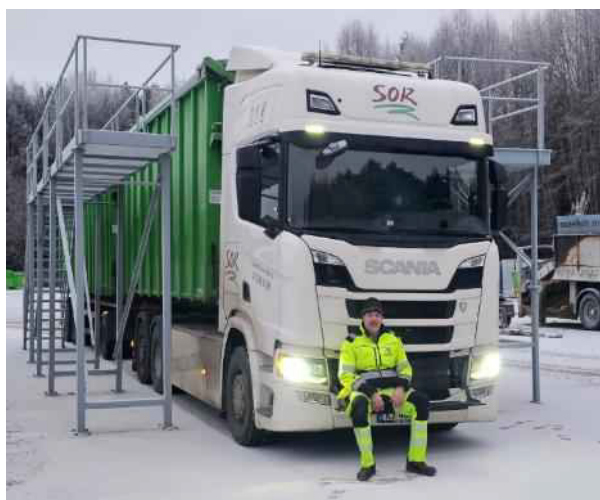
Figur 17 - Gangstillas for montering av sikkerhetsnett
