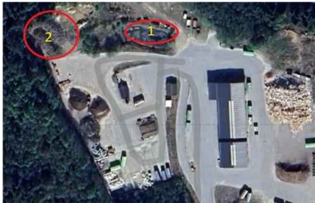
Figur 16 - Omlastningsanlegg - Kildal Miljøstasjon
